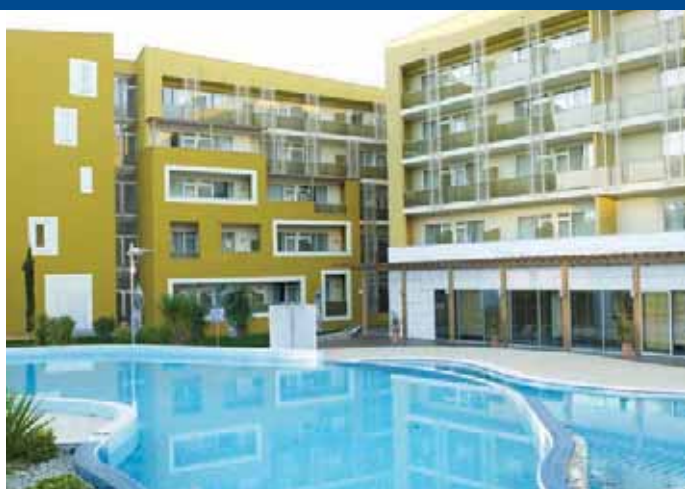
Slika 12. Prozračnost i odraz boja. Hotel Umag u Umagu, zaštićen Fasadex akrilatnom žbukom.
