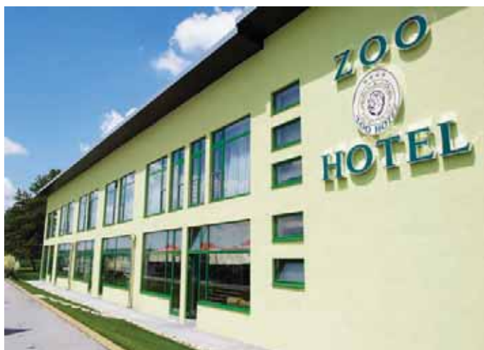
Slika 14. Smirenost zelenkaste ljepote. ZOO hotel u Osijeku. Objekt dekorativno zaštićen Fasadex akrilatnom žbukom.
